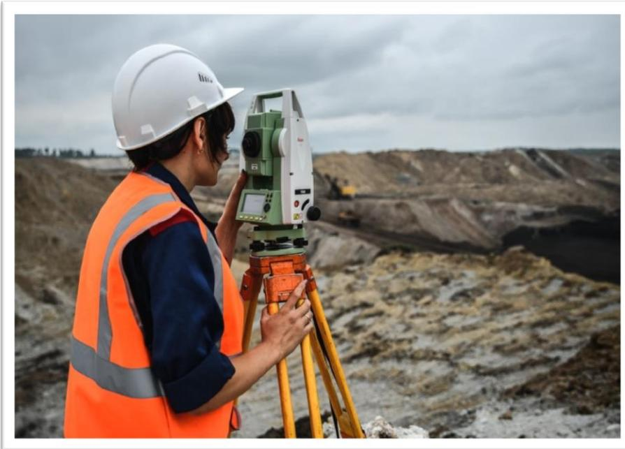
При работе на горных разработках маркшейдеры следят за сдвигами горных пород, отвалами пустых пород, предотвращают их сдвиги и принимают решения о продолжении или приостановке работ, если это необходимо.
