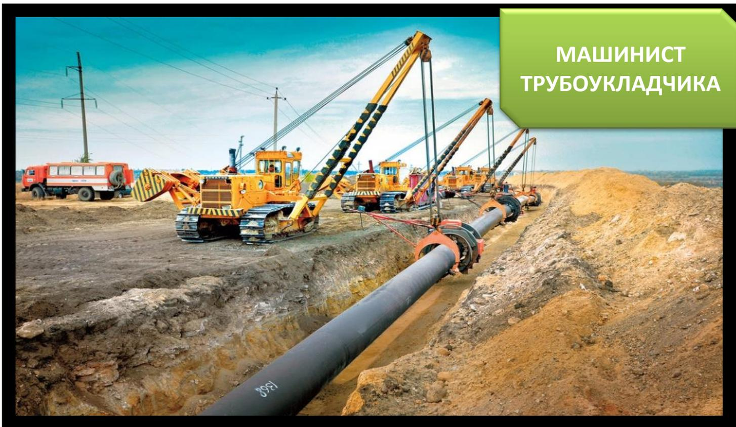
**Машинист трубоукладчика — это специалист широкого профиля, который выполняет ряд различных задач. Рабочие осуществляют укладку труб в траншею, участвуют в сварочно-монтажных работах, переизоляции и ремонте действующих газопроводов, выполняют транспортировку, погрузку и разгрузку труб и плетей, принимают участие в монтаже габаритного оборудования.**
