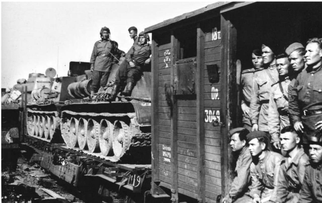
Эшелон Уральского добровольческого танкового корпуса, направляющийся на фронт. На платформах танки Т-34-76 и САУ СУ-12
